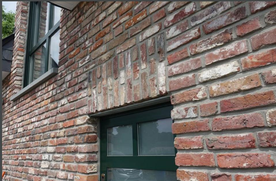
Fensterlaibung mit Winkelriemchen ausgeführt, Sturz mit Grenadierschicht
