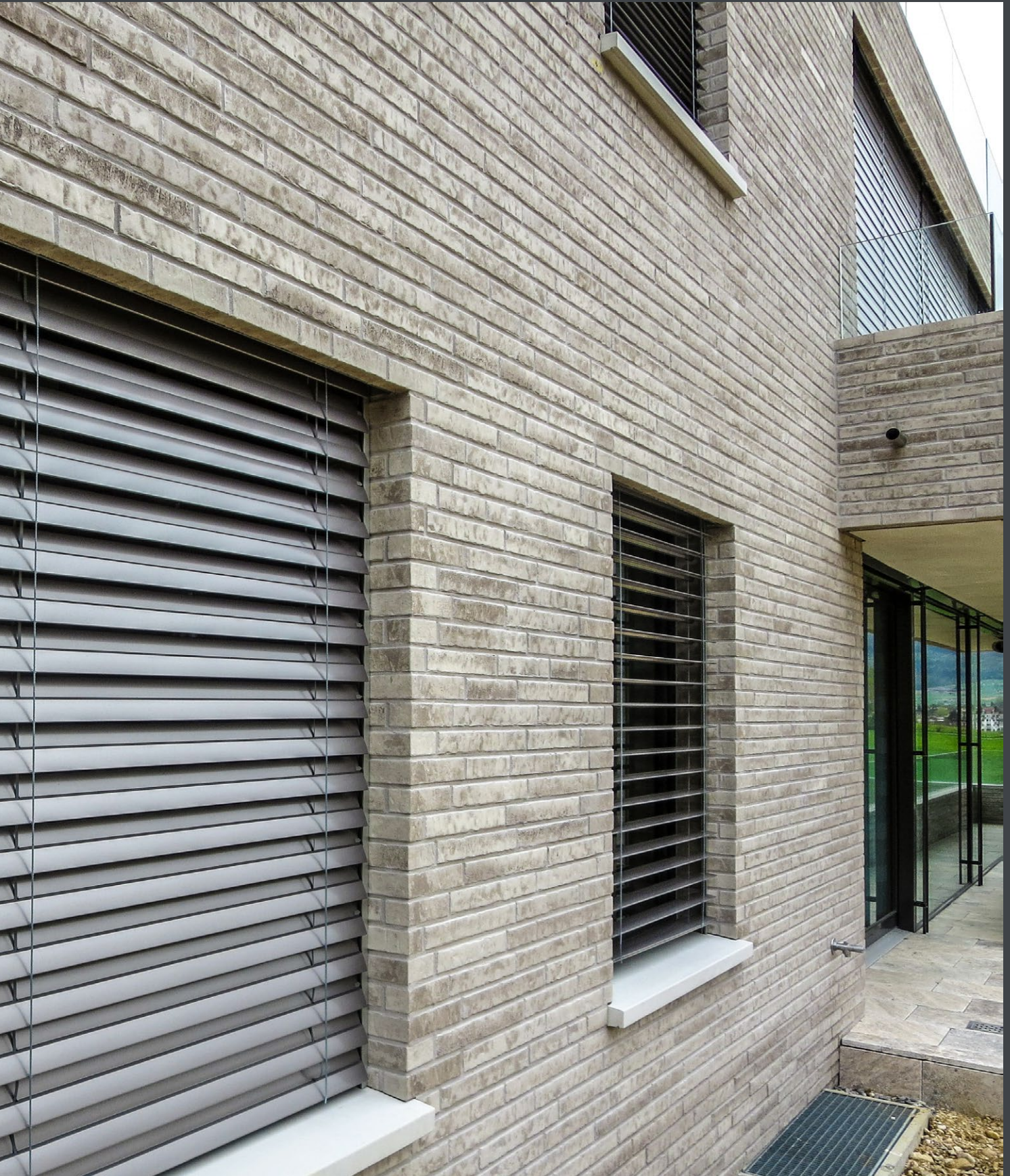
Wohngebäude, Oberwil Fensterbänke
